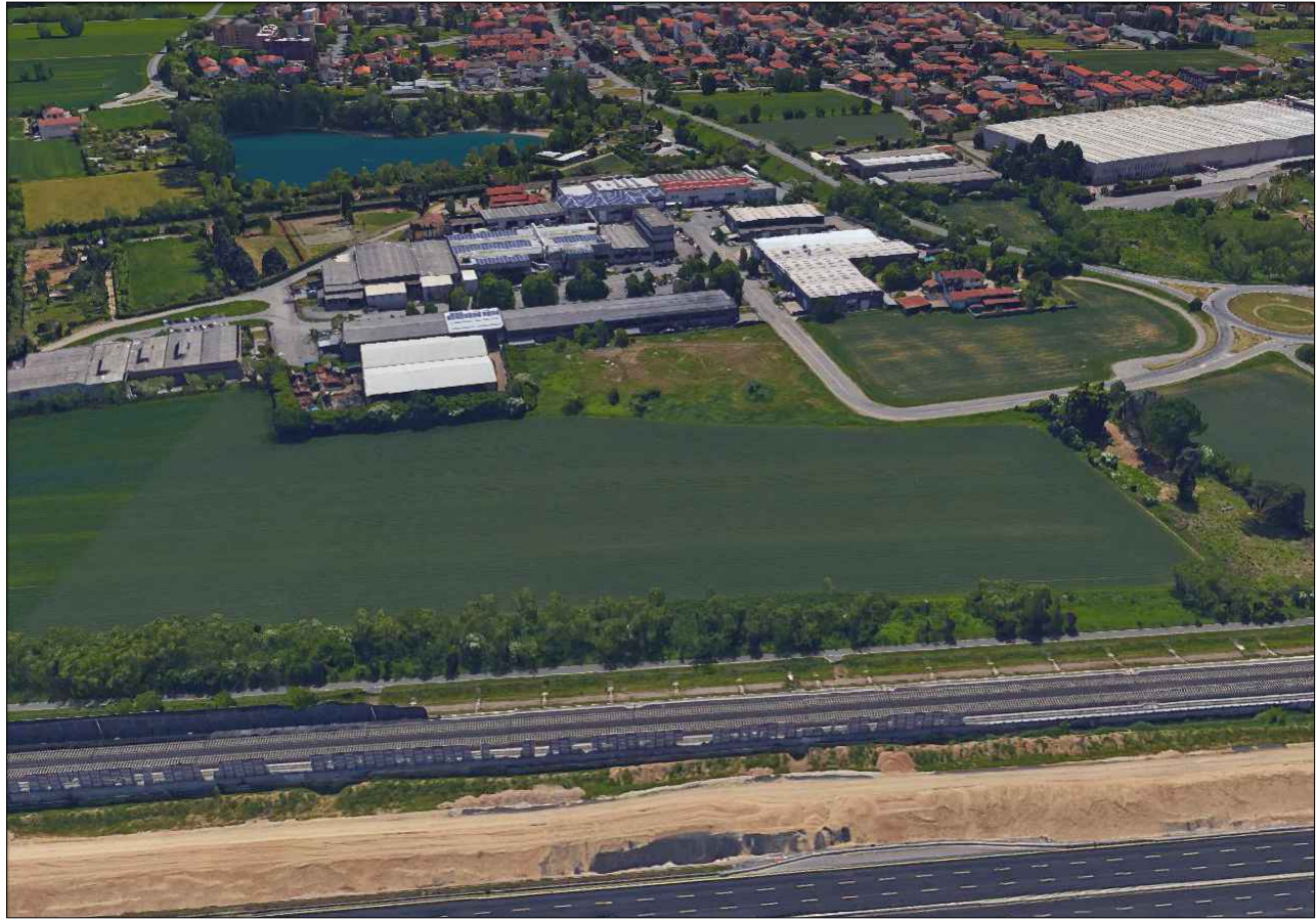
VISTA AEREA DA NORD
